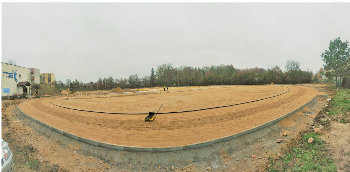
Zdjęcie z terenu budowy z 30.11.2022 r.
