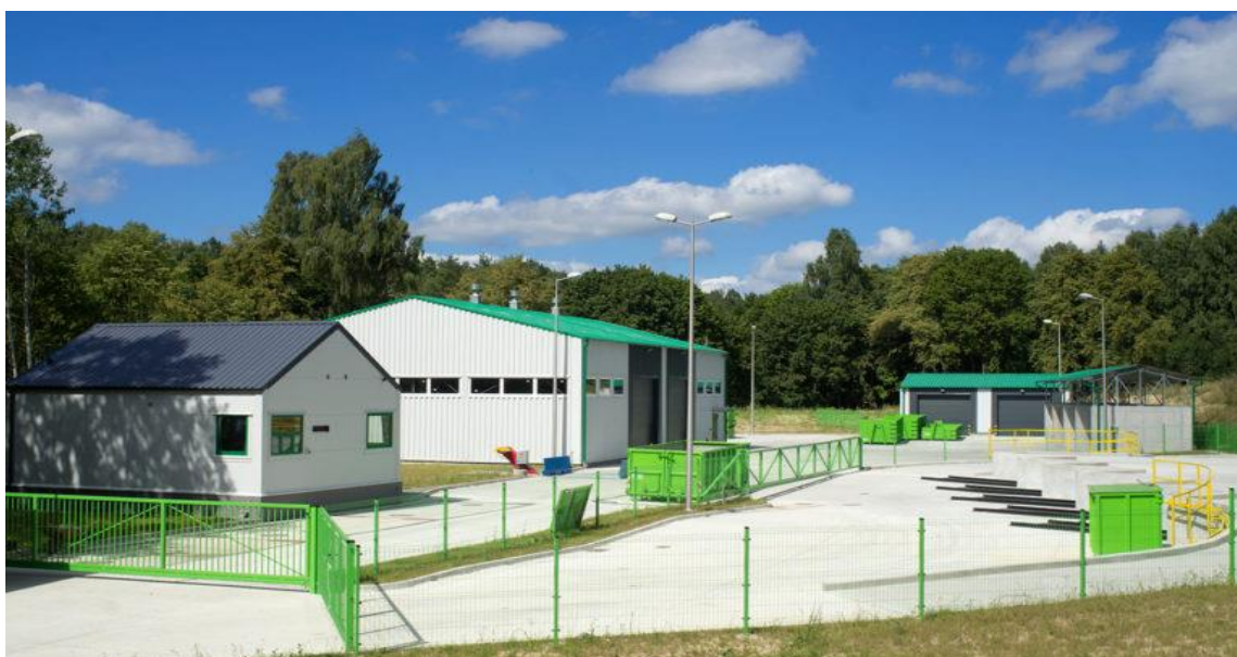
Stacja przeładunkowa odpadów Trelkowo.
