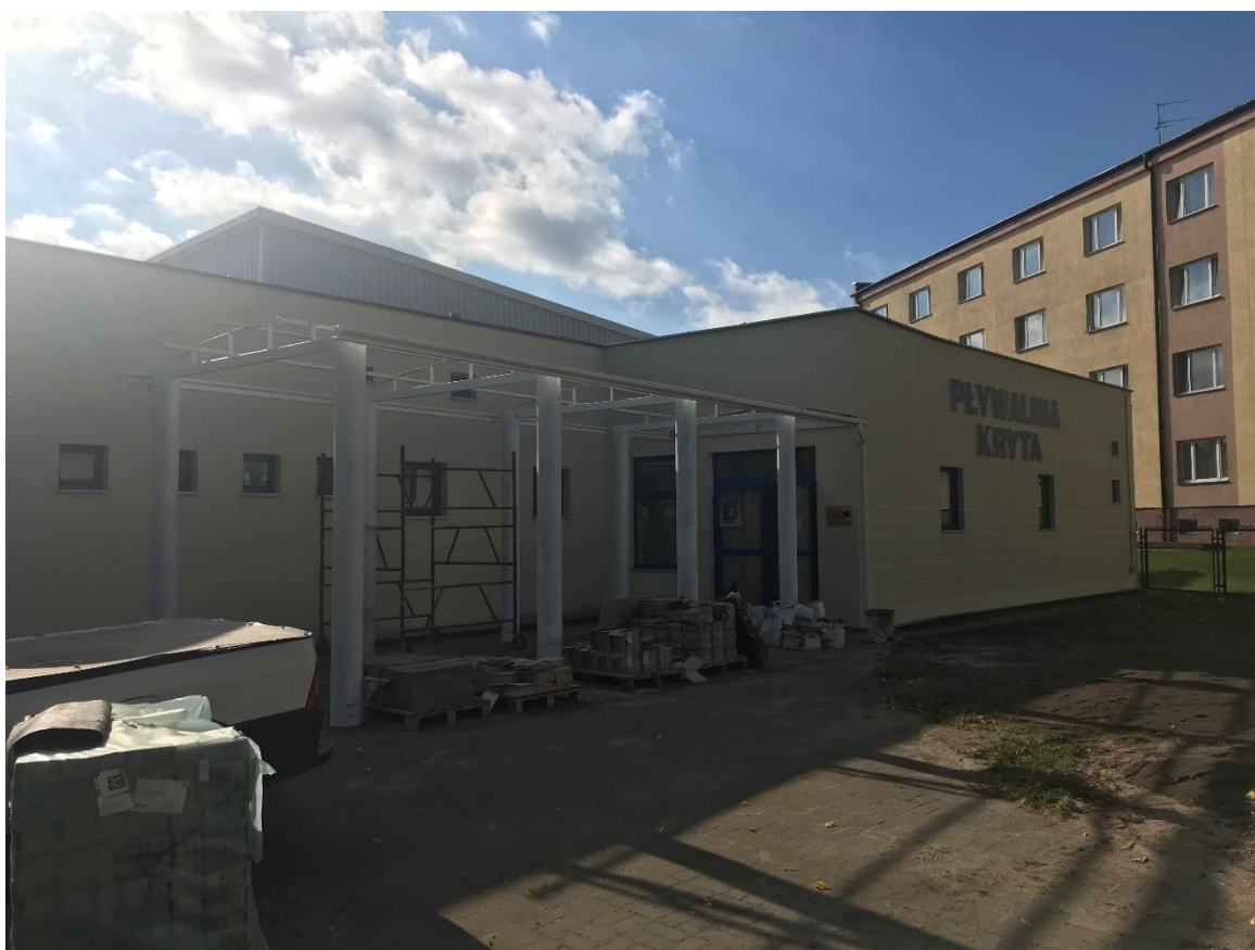
Fotografia 20. Basen Wyższej Szkoły Policji w Szczytnie podczas remontu (Fot. L. Pietrzak).
