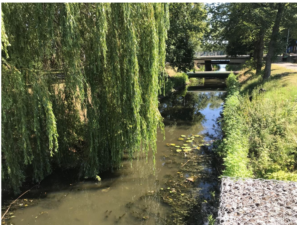
Fotografia 10. Kanał łączący Jez. Domowe Duże i Jez. Domowe Małe. Widoczny nisko zawieszony kolektor kanalizacji deszczowej i most na ul. Mickiewicza (Fot. L. Pietrzak).
